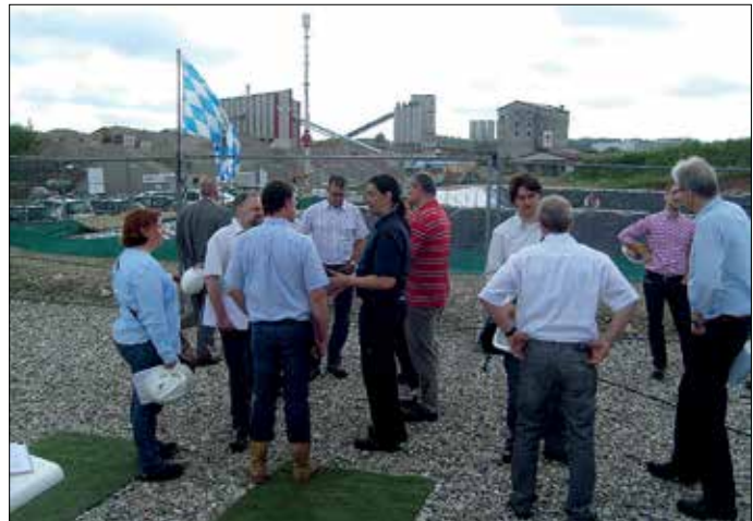
Abb. 5: Tagungsteilnehmer auf der Baustelle der geplanten Geothermieranlage Traunreut
