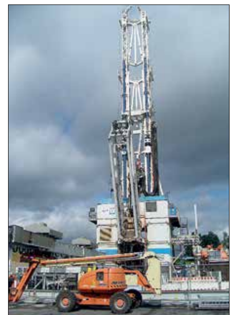
Abb. 6: Die Anger's Söhne Bohr- und Brunnenbaugesellschaft bringt mit der elektrohydraulischen Bohranlage „Innovarig“ modernste Technologie zum Einsatz
